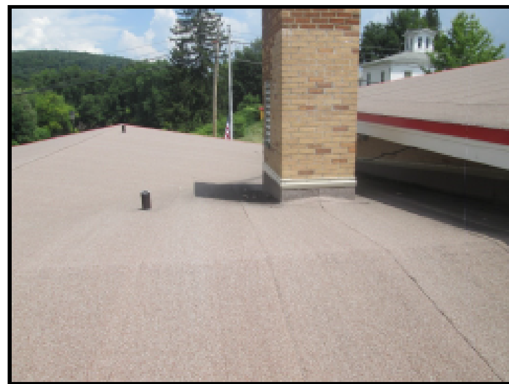
(D) EXISTING PHOTO - MAIN ROOF IV & CHIMNEY
